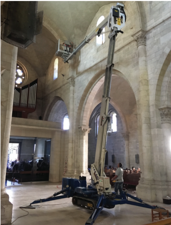
Auf einer großen Hebebühne werden die Wände der Erlöserkirche auf geschädigte Steine untersucht; Fotos: © Wolfgang Schmidt
