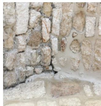
Dunkler Mörtel links aus der Kreuzfahrerezeit, heller Zement rechts aus dem letzten Jahrhundert;
