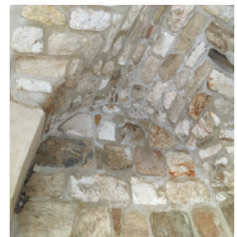
Rechts oben sieht man eine Lücke, hier hat sich ein Stein bereits aufgelöst, links eine Testfläche, die den angestrebten Zustand zeigt.
