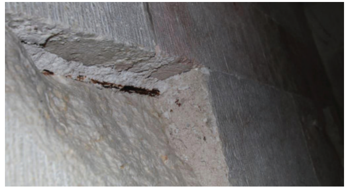
Geschädigter Stein. Im oberen Bereich des Steins kann man die verrostete Eisenklammer erkennen; Foto: © Gerhard Buchenau
